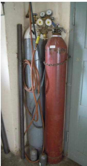
Artikel 4.1.2 Die Gas- und Sauerstoffflaschen für Schweißarbeiten. privat Bild
